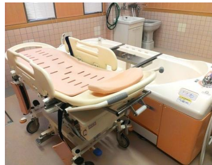
圖：水療功能機械入浴設施
